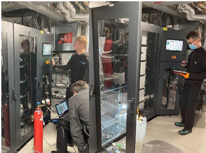
Brennstoffzellen-Schrank. Quelle: Meyer Werft GmbH & Co. KG
