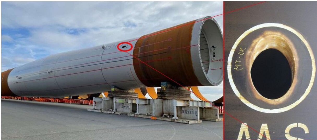
Stahlbautypisches Konstruktionsdetail mit charakteristischem Ermüdungsversagen infolge von Spannungsüberhöhung durch Kerbwirkung. Quellen: (links) www.industr.com/de/erste-xxl-monopiles-stechen-in-see-2645672 , (rechts) www.subenesol.co.uk/Products/SUB-BUNG-OWF-S-Subsea-Diver-Installed-Bungs
