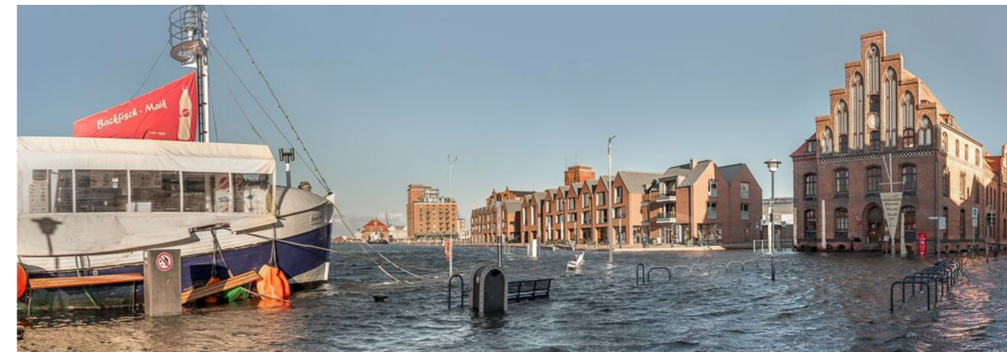
Alter Hafen Wismar, Sturmflut am 2. Januar 2019. Quelle: Hochschule Wismar
