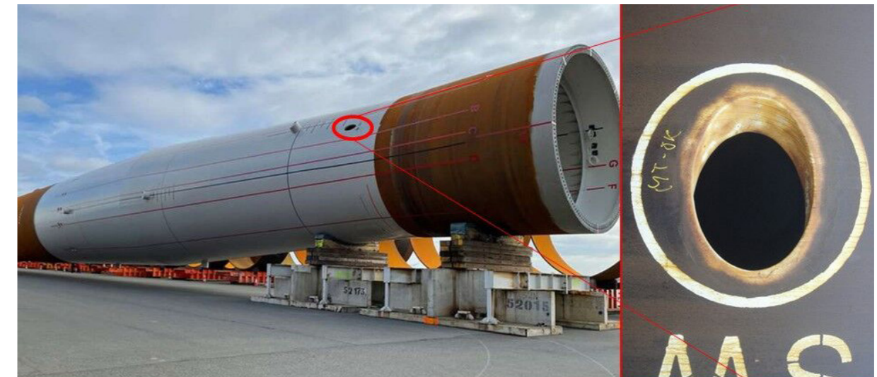
Stahlbautypisches Konstruktionsdetail mit charakteristischem Ermüdungsversagen infolge von Spannungsüberhöhung durch Kerbwirkung. Quellen: (links) www.industr.com/de/erste-xxl-monopiles-stechen-in-see-2645672 , (rechts) www.subenesol.co.uk/Products/SUB-BUNG-OWF-S-Subsea-Diver-Installed-Bungs
