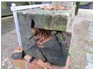
Abb. 2: Starker Braunfäuleschaden Schwelle
