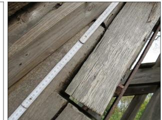
Abb. 5: Öffnung Verbindung, falsche Anordnung
