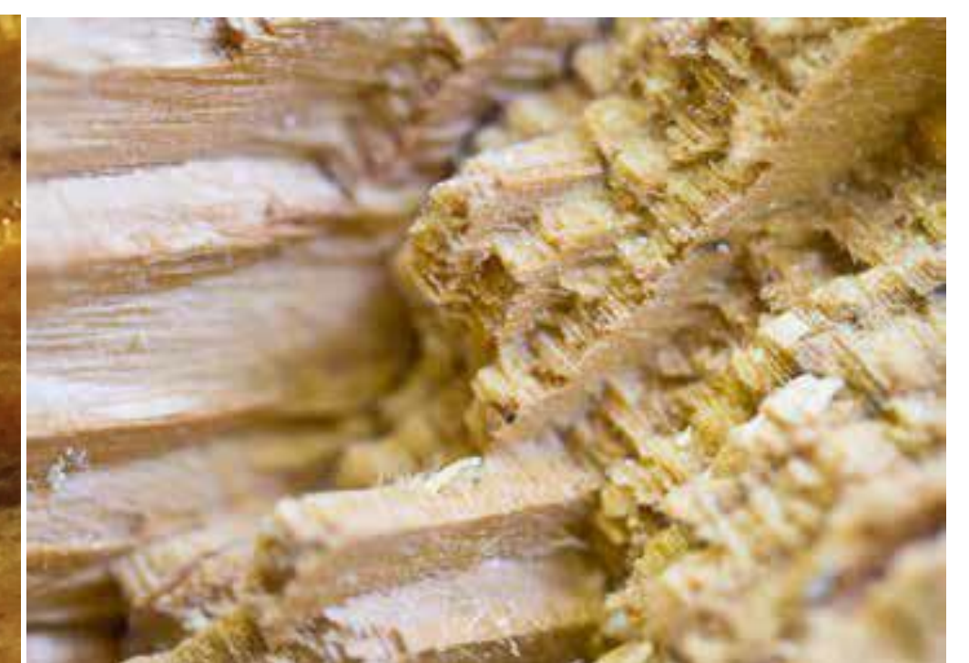
Abb. 8 Kurzfasriges Bruchbild an Fichtenholz aus einem Biogasfermenter
