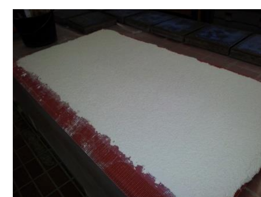
Verputzen der XPS-Platten
