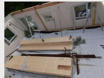
**Bild 5:** Mit Siloplane abgedeckte Decke als temporäres Dach (eigene Darstellung)
