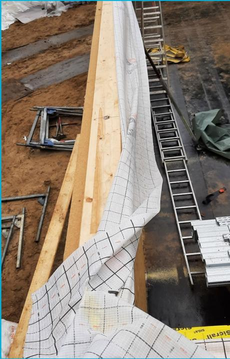
**Bild 1:** Gut geplante, jedoch nicht ausreichend gesicherte Wandkopfabdichtung (eigene Darstellung)
