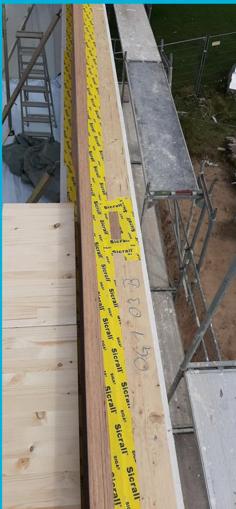
**Bild 2:** Vollständig abgeklebte Bauteilfugen schützen das Bauteil bei Regen vor einsickerndem Wasser (eigene Darstellung).
