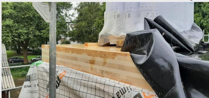
**Bild 4:** Kollision des geplanten Feuchteschutzes mit der Ausführung und damit verbundene Hinterlaufung des Bauteils (eigene Darstellung)
