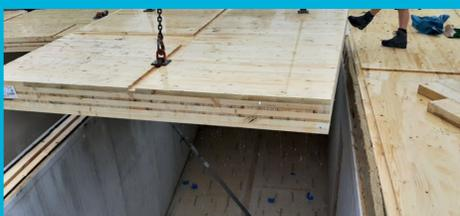
**Bild 3:** Brettsperrelemente werden bei Regen verlegt (eigene Darstellung).
