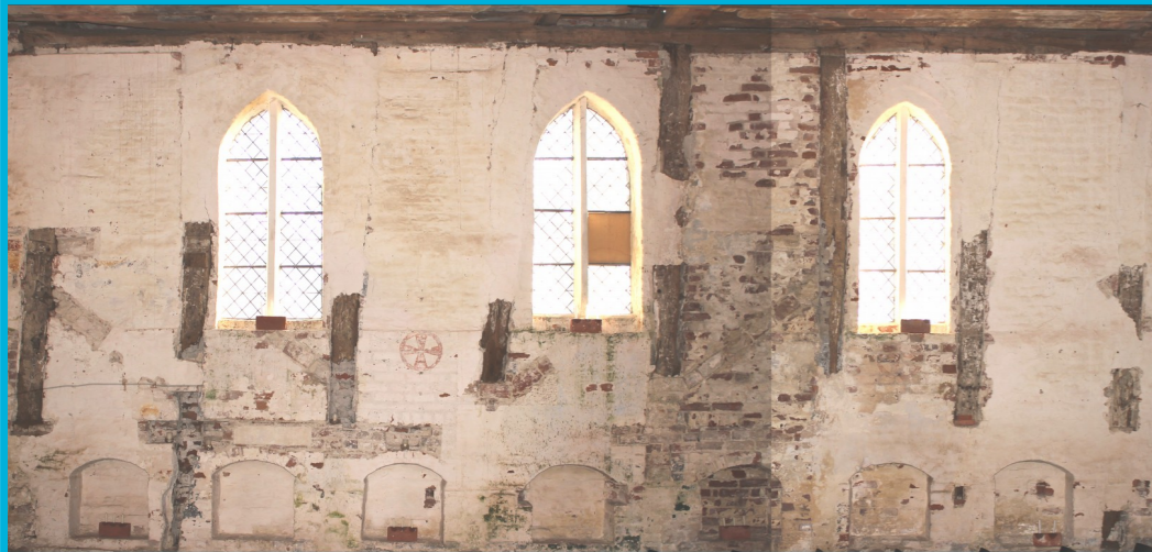
Abb. 2: Erhaltende Fachwerkständer in der Südwand
