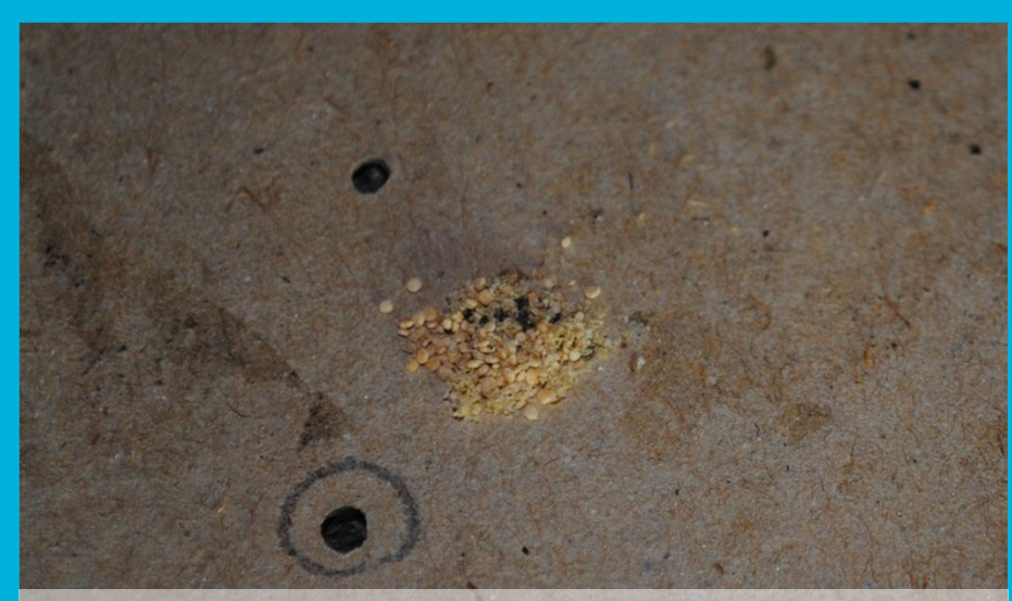
Abb. 1: Papierabklebung mit Bohrmehl des Gescheckten Nagekäfers
