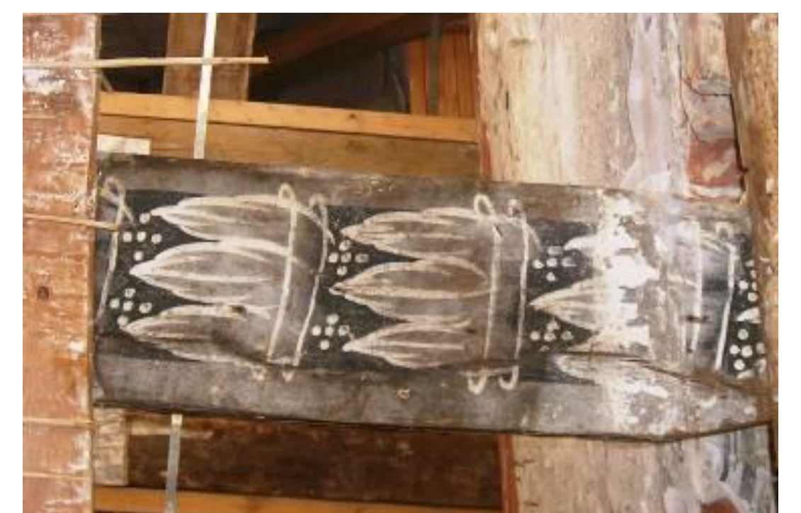
Abbildung 7: Teil eines Deckenbalkens
