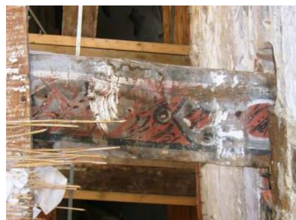
Abbildung 6: Teil eines Deckenbolzbalkens
