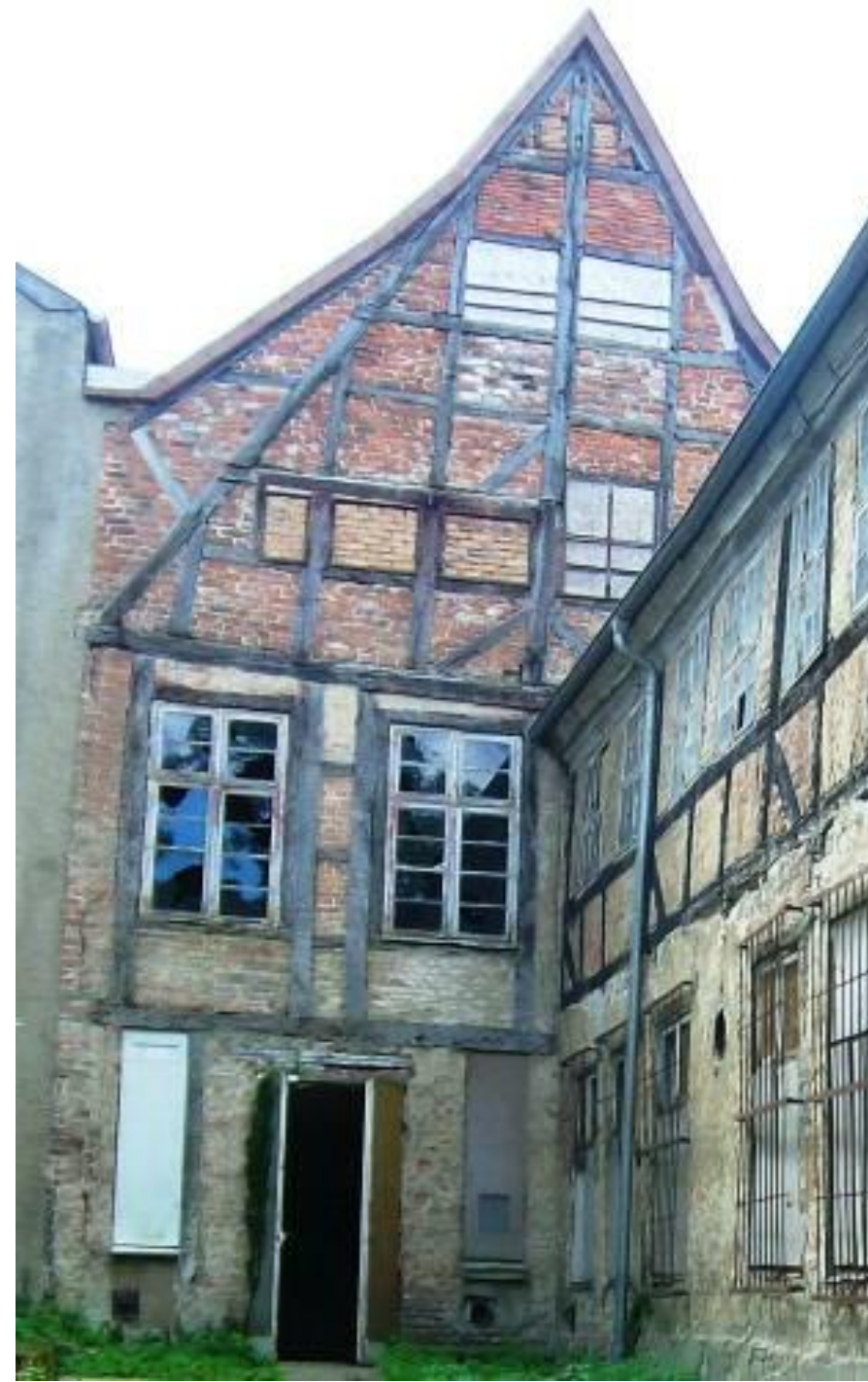
Abbildung 2: Lübsche Straße 23, teilweise fachwerksichtiger Rückgiebel und Teile der östlichen Kemladenfassade
