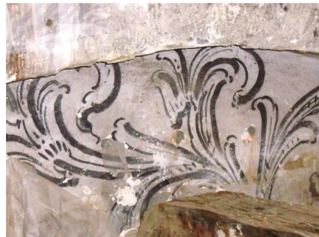
Abbildung 5: Befundbereich B Ausschnitt der Rundbogennische der östlichen Brandwand
