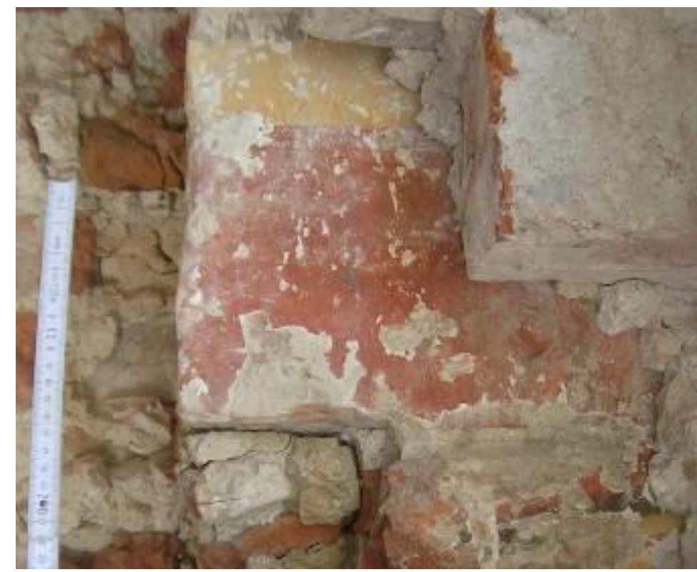
Abbildung 4: Befundbereich A Teil einer Vormauerschale der östlichen Brandwand
