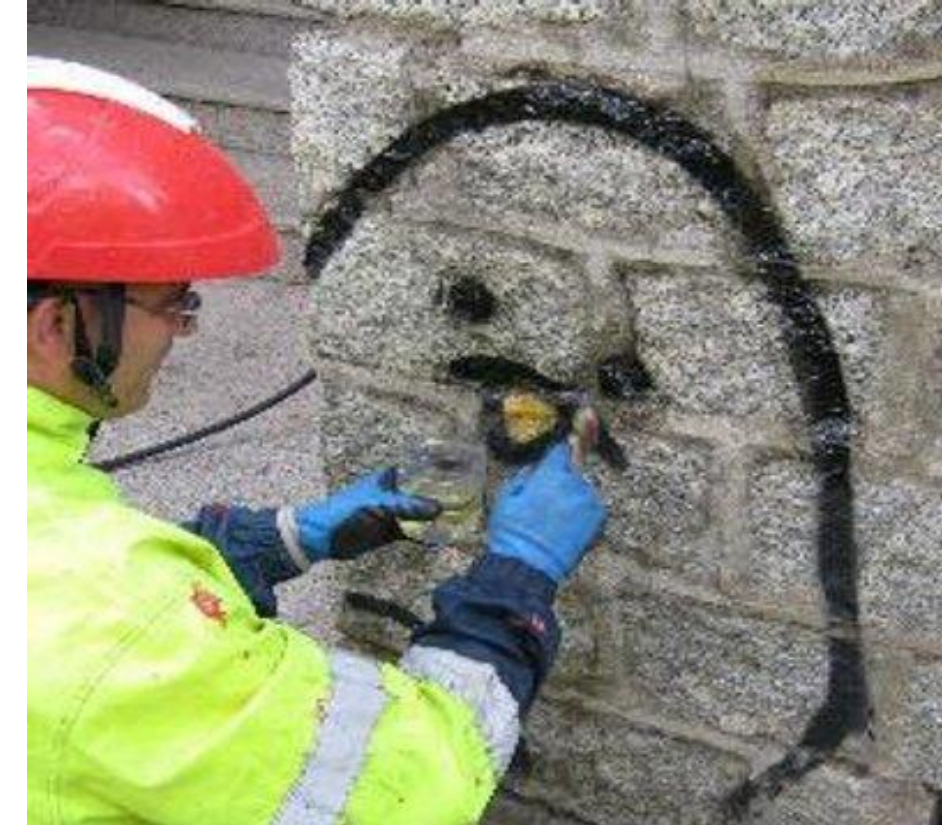
Abb. 2 Reinigung eines Graffitis
