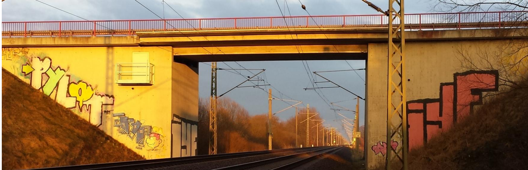
Bild 1: Überführung einer Straße
