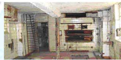
Ansicht der Backstube mit Blick vom Vorderhaus auf den Ofen.
