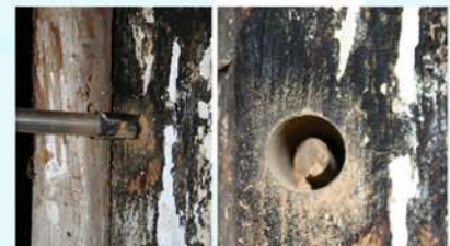
Dendrochronologische Untersuchung: Probenahme mit einem Kernlochbohrer am Pfosten Nummer 3 des Vorderhauses und fertig gebohrte Probe
