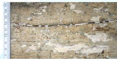
Schaden durch den Gewöhnlichen Nagekäfer am Kehlbalken, Gebinde Nummer 3; Befallsintensität der Größe III, über 50 Ausfluslöcher auf 1dm²
