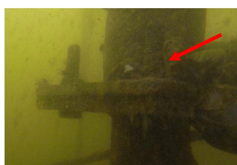
Abb. 3 Verschraubter Drehsteifenstoß
