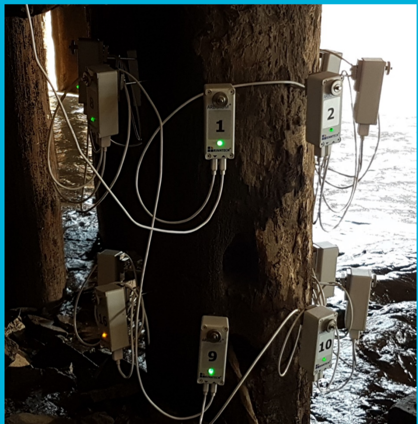
Abb. 3: Messung an der Pfahlgründung
