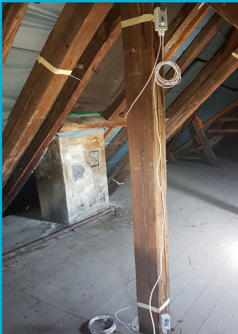
Abb. 2: Messung an der Stützenkonstruktion
